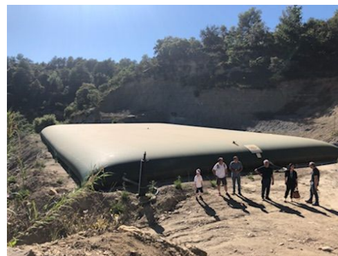
Bâche de stockage de 1 000m3
